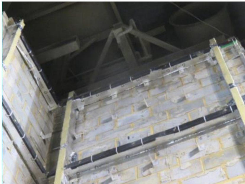
Gambar 34 . Penggunaan Penghalang Rongga ( Cavity Fire Barrier ) berbasis Intumescent (Hilti & BRE Global).
