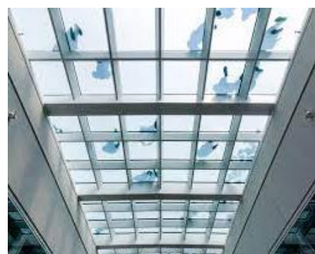
Gambar 18b - Kanopi atau skylight
