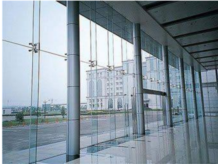
Gambar 3 - Sistem Dinding Kaca dengan dukungan glass fin
