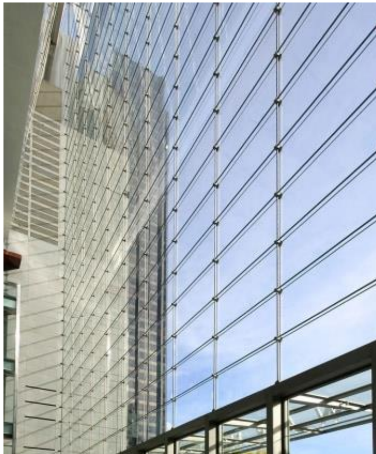
Gambar 4 - Sistem Dinding Kaca dengan dukungan kabel jaring ( cable net )
