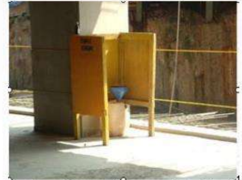
TEMPAT BUANG AIR KECIL DI LOKASI PROYEK
